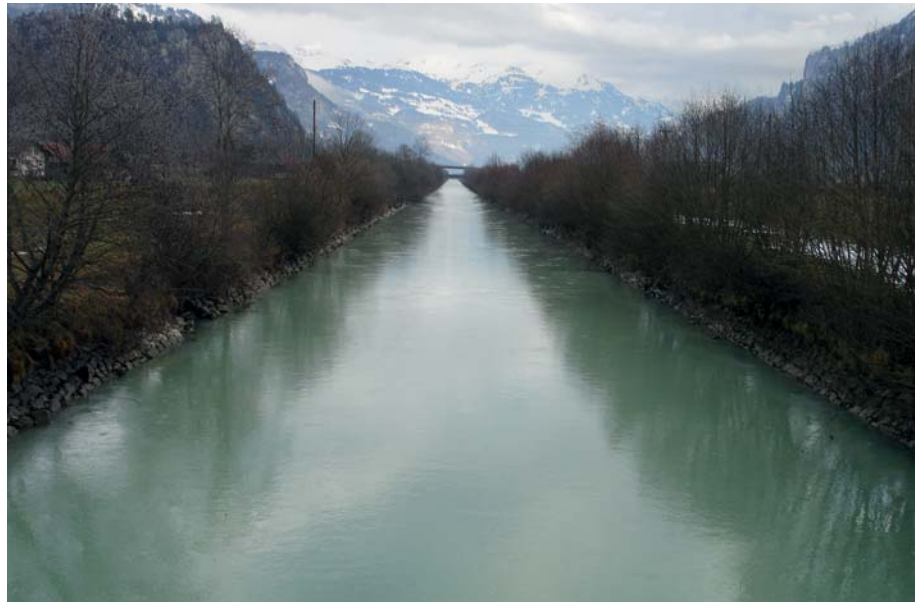
Bild 2. Kanalisierter Abschnitt der Hasliaare kurz oberhalb der Mündung in den Brienzensee, Blick flussaufwärts.
